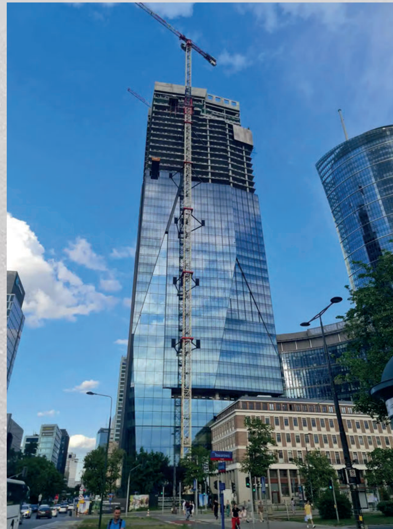
The Bridge 40 kondygnacji
